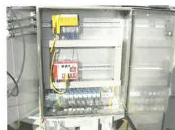
Universell einsetzbar für Sicherheit oder Standard oder einer Kombination aus beidem: Mit Standard-Kopfmodulen kommuniziert die dezentrale Steuerungsplattform PSSUniversal auch ausschließlich über Standardfeldbusse.
